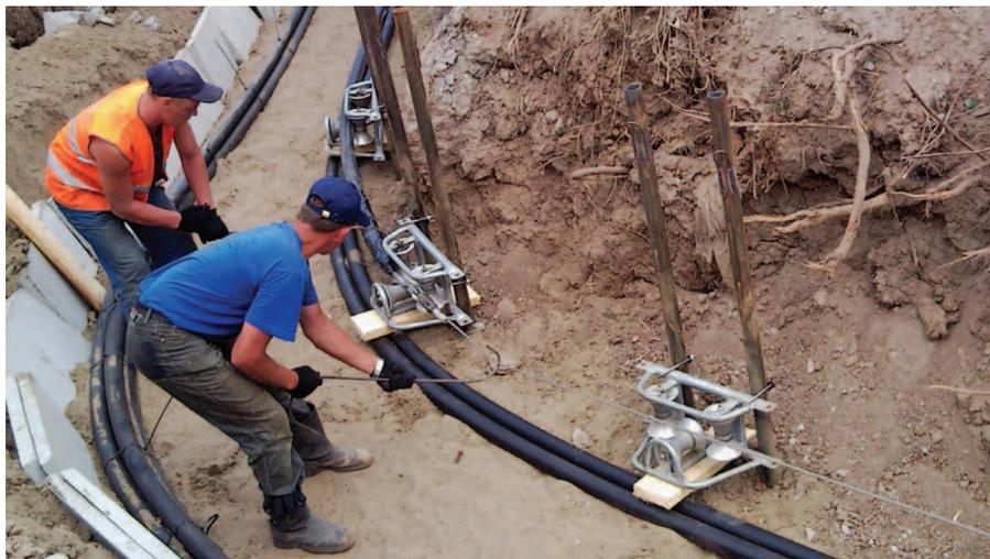
Рисунок 19. Процесс прокладки кабеля. Оттяжка крюками в повороте
